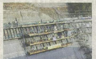
鹿島は型枠メーカーのドカジャパンと共同で、ダム工事で使うコンクリート型枠を自動でスライドさせるシステムを開発した。3面
